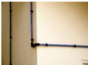
Tubes et raccords pour la réalisation de réseaux d'air comprimé.
